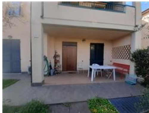
viata esterna zona ingresso
